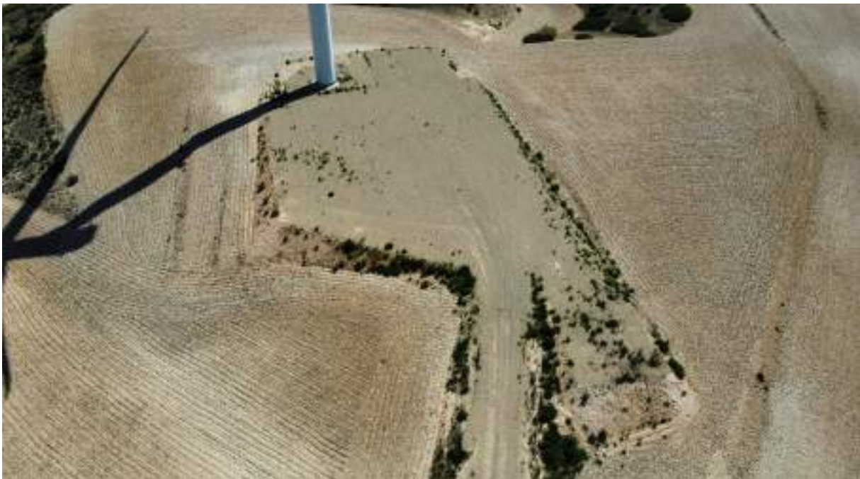
Foto nº12.: Plataforma del Aerogenerador T-12.
