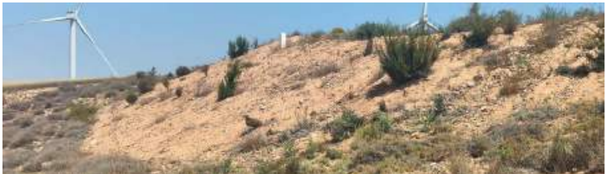
Foto nº33.: T-13: Plantación en el talud en terraplén de la plataforma.
