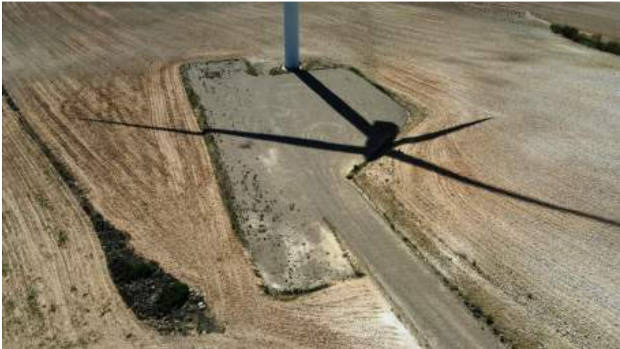
Foto nº5.: Plataforma del Aerogenerador T-05.
