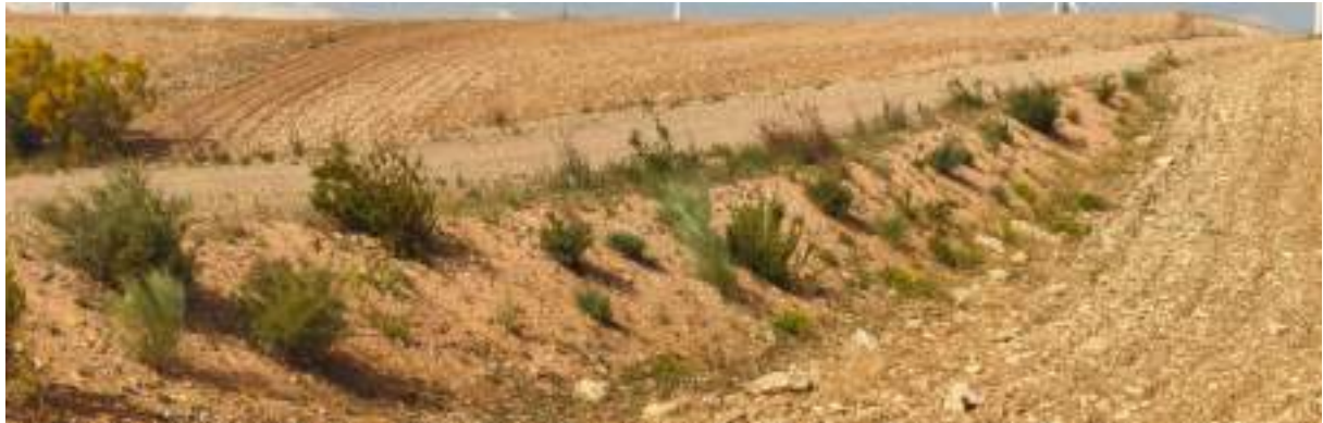
Foto nº30.: T-12: Plantación en el talud en terraplén del vial de acceso, orientación norte.
