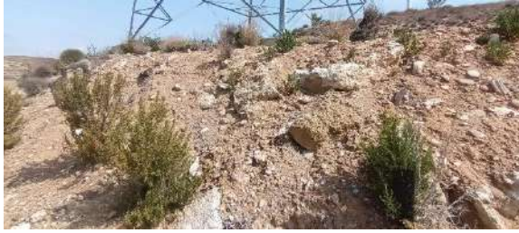
Estado general de los taludes restaurados (AP-19)
