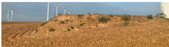
Estado general de los taludes restaurados (T-04)
