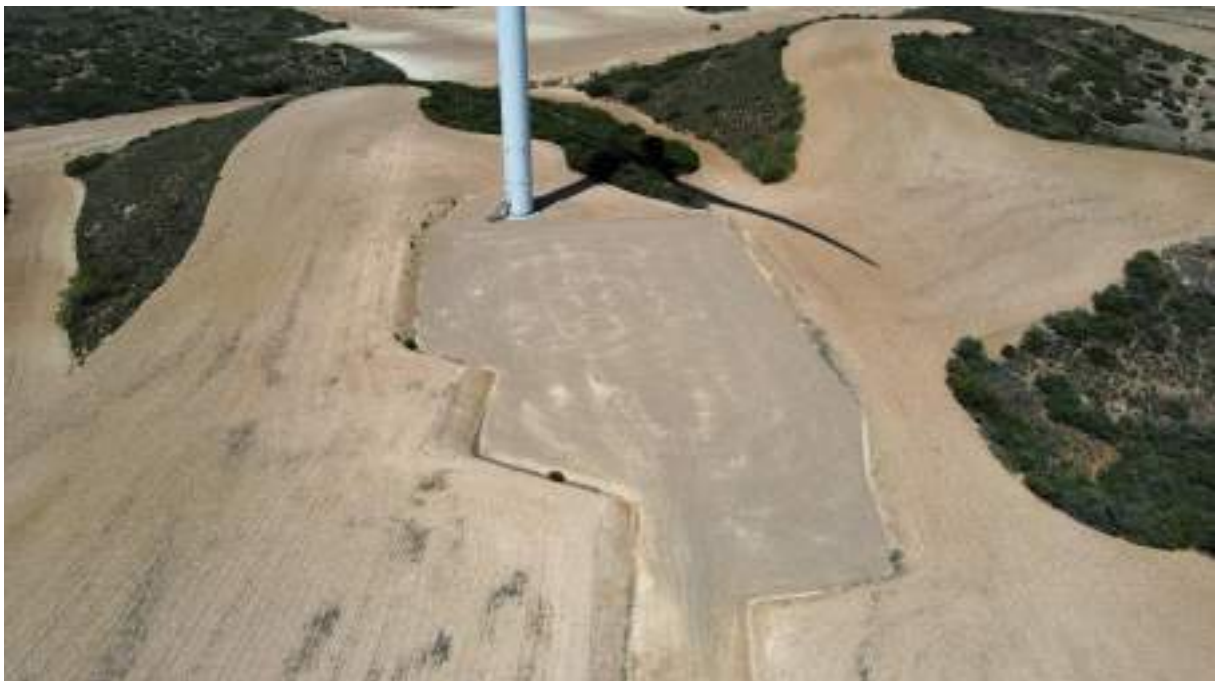
Foto nº2.: Plataforma del Aerogenerador T-02.
