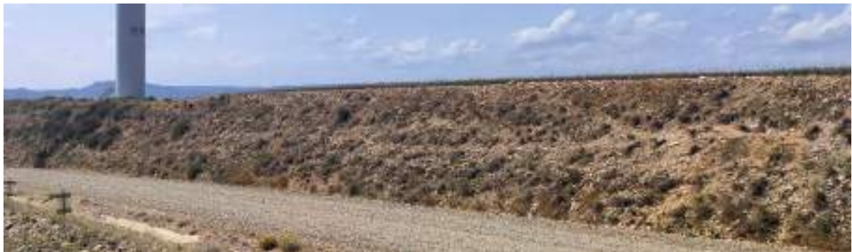
Foto nº32.: T-13: Hidrosiembra sobre talud en desmorte junto al camino de acceso.
