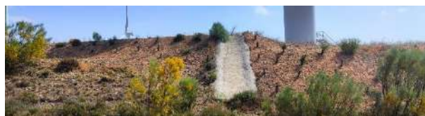
Estado general de los taludes restaurados (T-06)
