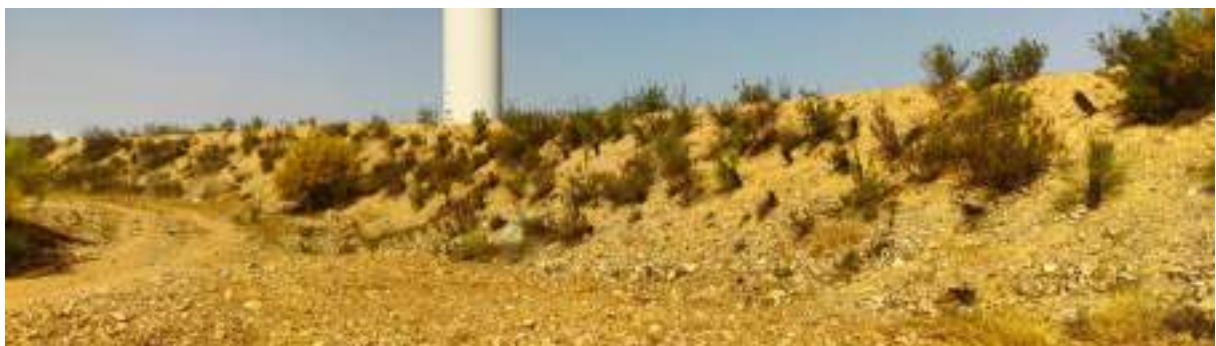
Foto nº25.: T-07: Plantación en el talud en terraplén del vial.
