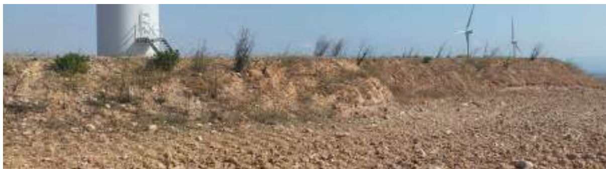
Foto nº28.: T-10: Hidrosiembra en el talud en terraplén de la plataforma.
