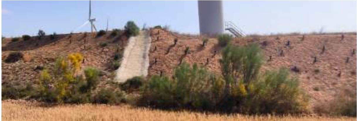
Foto nº41.: T-06: Detalle canalización de agua.
