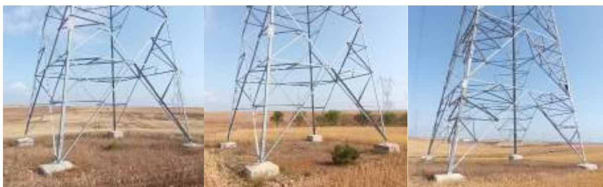
Foto nº17.: Estado general de los apoyos. Ejemplo del Apoyo nº 8, Apoyo nº 9 y Apoyo nº 11 de la LAAT.
