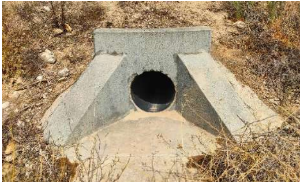
Foto nº42.: T-06: Drenaje del vial.
