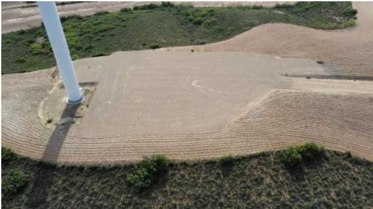
Foto nº1.: Plataforma del Aerogenerador T-01.
