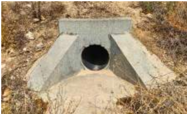
Foto nº42.: T-06: Drenaje del vial.
