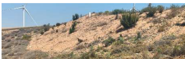
Estado general de los taludes restaurados (T-13)
