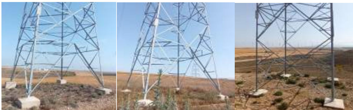
Foto nº18.: Estado general de los apoyos. Ejemplo del Apoyo nº 12, Apoyo nº 13 y Apoyo nº 14 de la LAAT.
