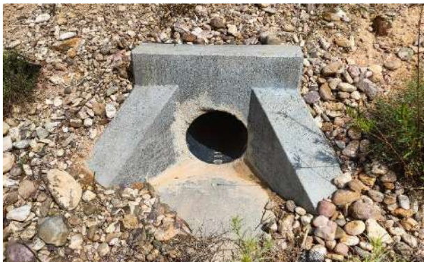
Foto nº43.: T-07: Drenaje del vial.
