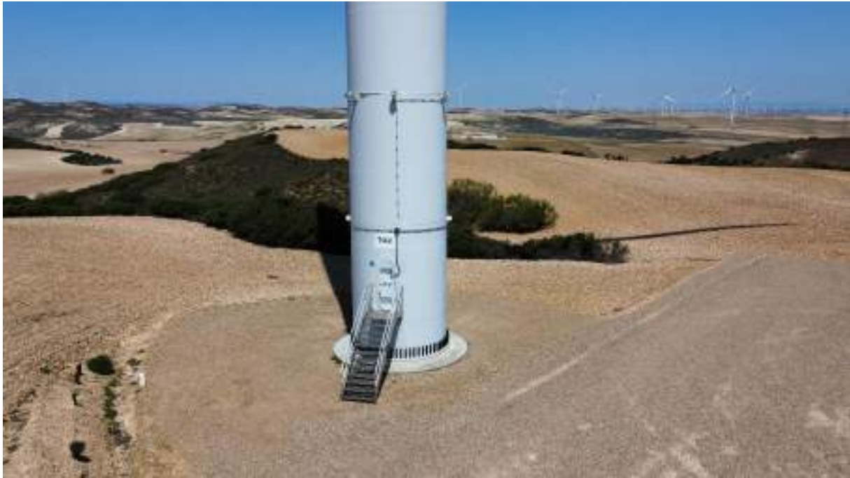
Foto nº15.: Instalación Dispositivo DTBird en aerogenerador T-02.
