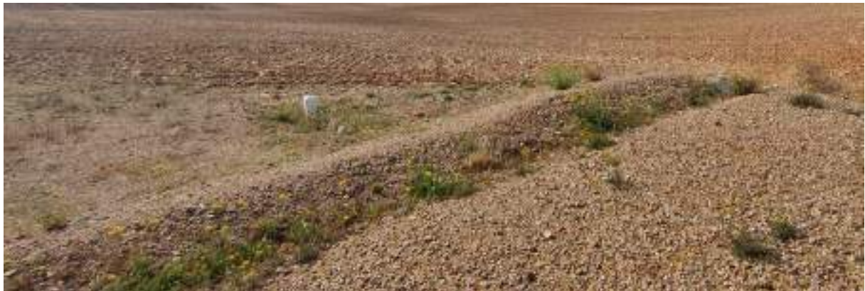
Foto nº39.: T-05: Canalización de agua para evitar escorrentías por el talud.
