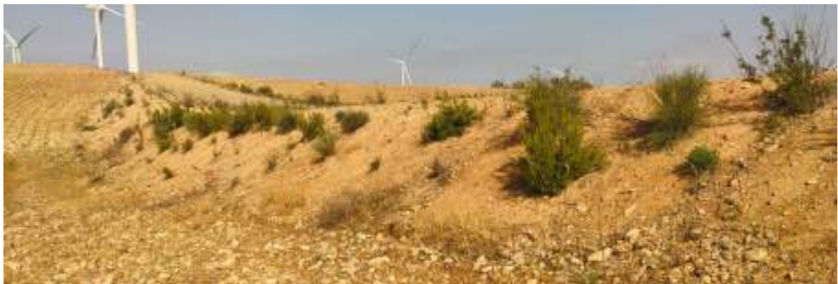
Foto nº31.: T-12: Plantación en el talud en terraplén del vial de acceso, orientación sur.
