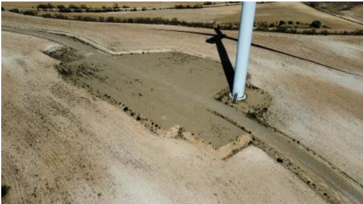
Foto nº10.: Plataforma del Aerogenerador T-10.
