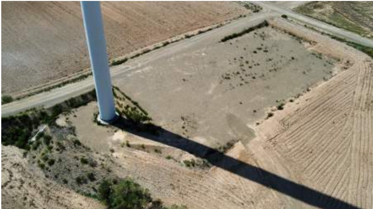
Foto nº7.: Plataforma del Aerogenerador T-07.
