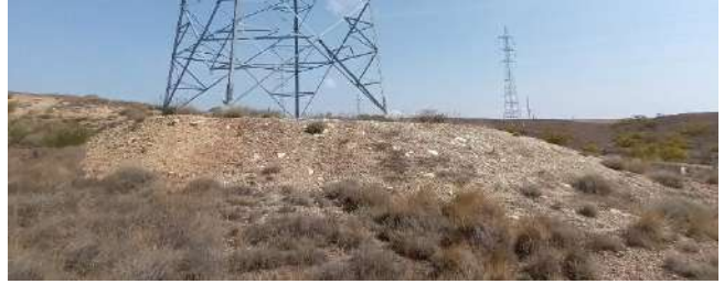
Estado general de los taludes restaurados (AP-20)
