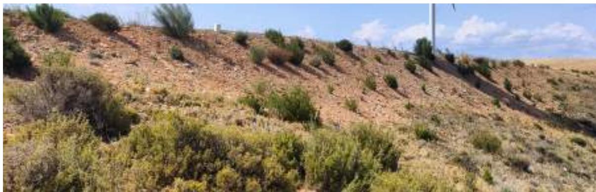
Foto nº34.: T-14: Plantación en el talud en terraplén de la plataforma.
