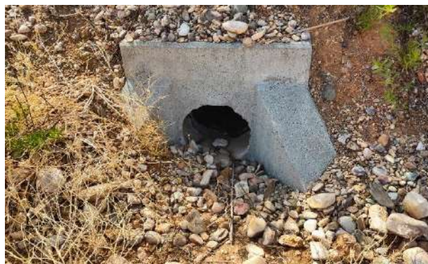
Foto nº43.: T-07: Drenaje del vial.
