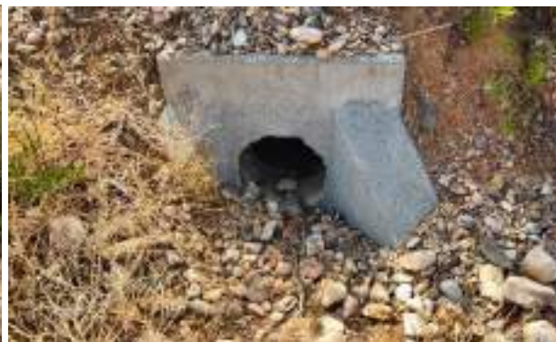
Foto nº43.: T-07: Drenaje del vial.
