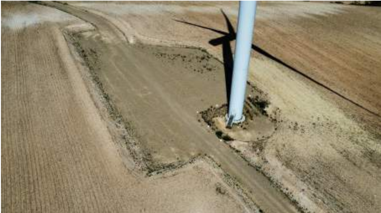
Foto nº11.: Plataforma del Aerogenerador T-11.
