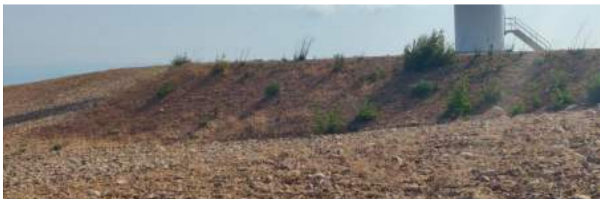
Foto nº29.: T-12: Plantación en el talud en terraplén de la plataforma.
