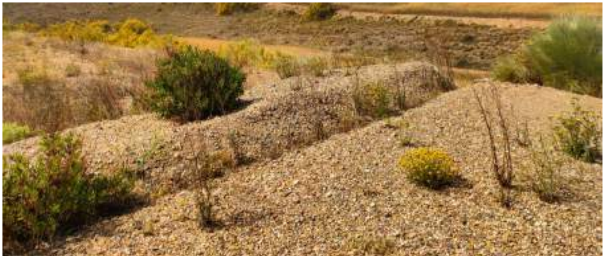
Foto nº40.: T-06: Canalización de agua para evitar escorrentías por el talud.
