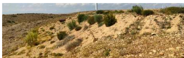
Estado general de los taludes restaurados (T-14)
