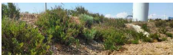
Estado general de los taludes restaurados (T-07)
