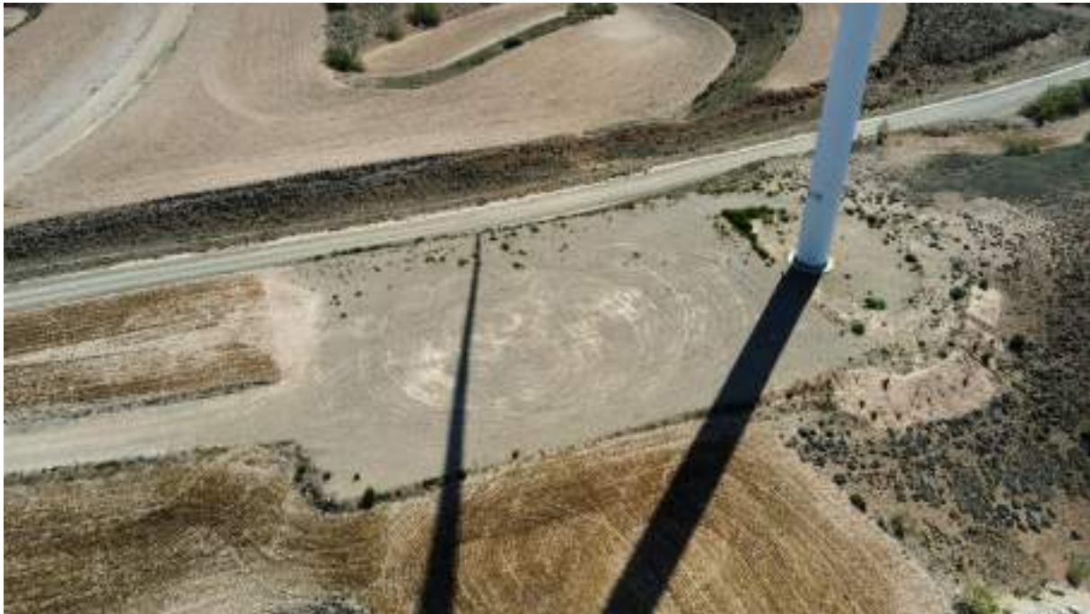
Foto nº13.: Plataforma del Aerogenerador T-13.
