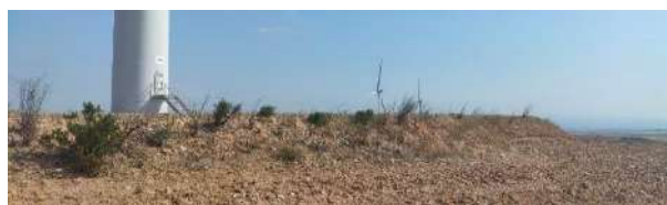
Estado general de los taludes restaurados (T-10)
