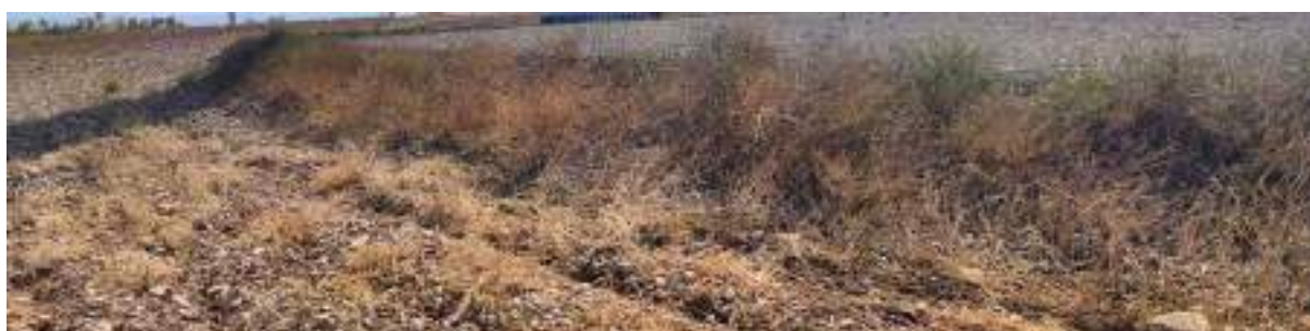
Foto nº27.: T-08: Hidrosiembra en el talud en terraplén de la plataforma.
