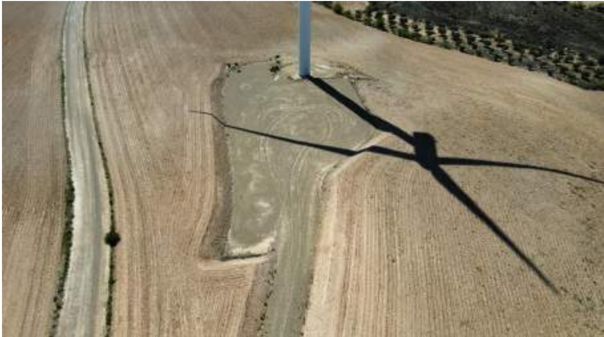
Foto nº9.: Plataforma del Aerogenerador T-09.
