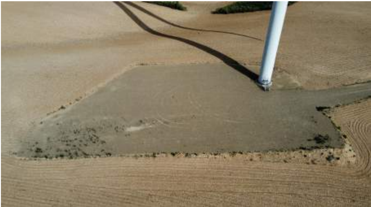
Foto nº4.: Plataforma del Aerogenerador T-04.
