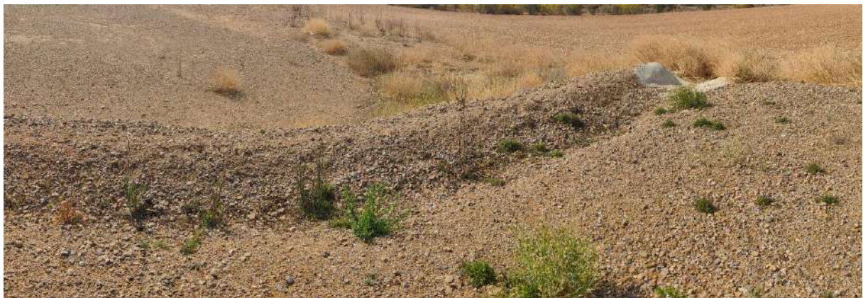
Foto nº45.: T-09: Canalización de agua para evitar escorrentías por el talud.
