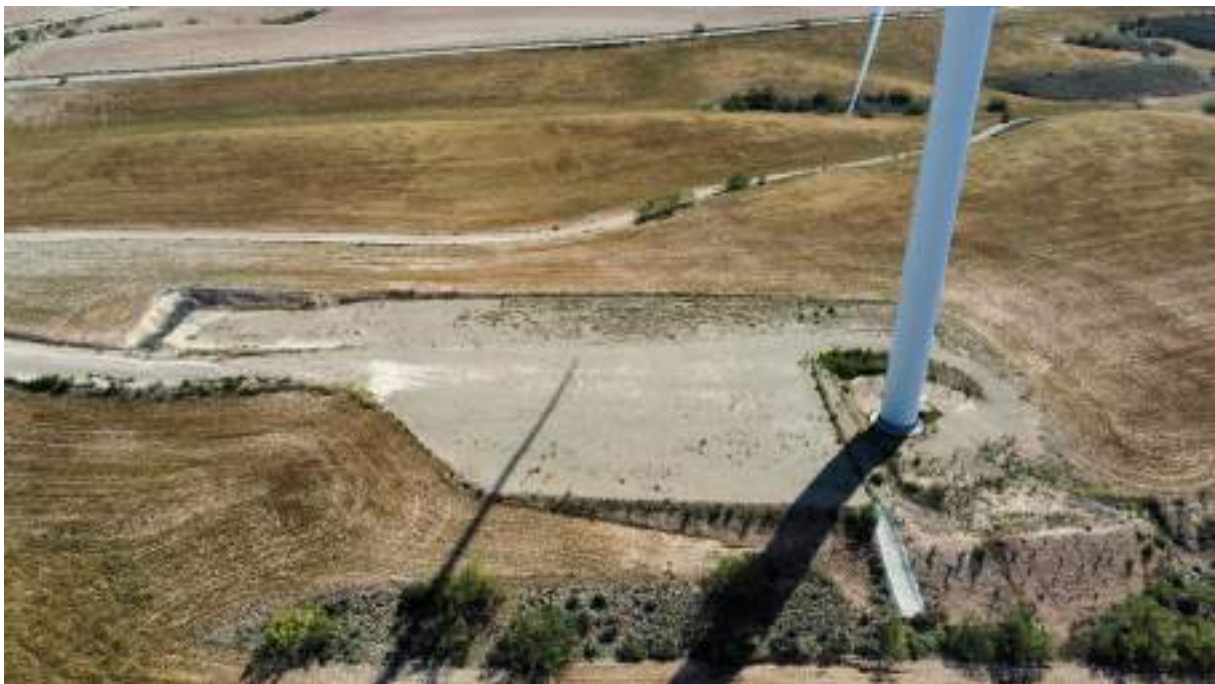
Foto nº6.: Plataforma del Aerogenerador T-06.
