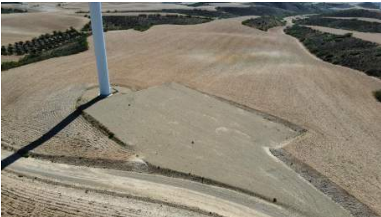
Foto nº8.: Plataforma del Aerogenerador T-08.
